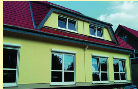
Doppelhaus mit Magnum Board Wohnungstrennwand
